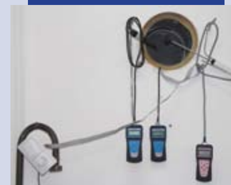
Фото 4. Образец ДПВСВ «УВРК-50», установленный для проведения испытаний (вид из помещения)
